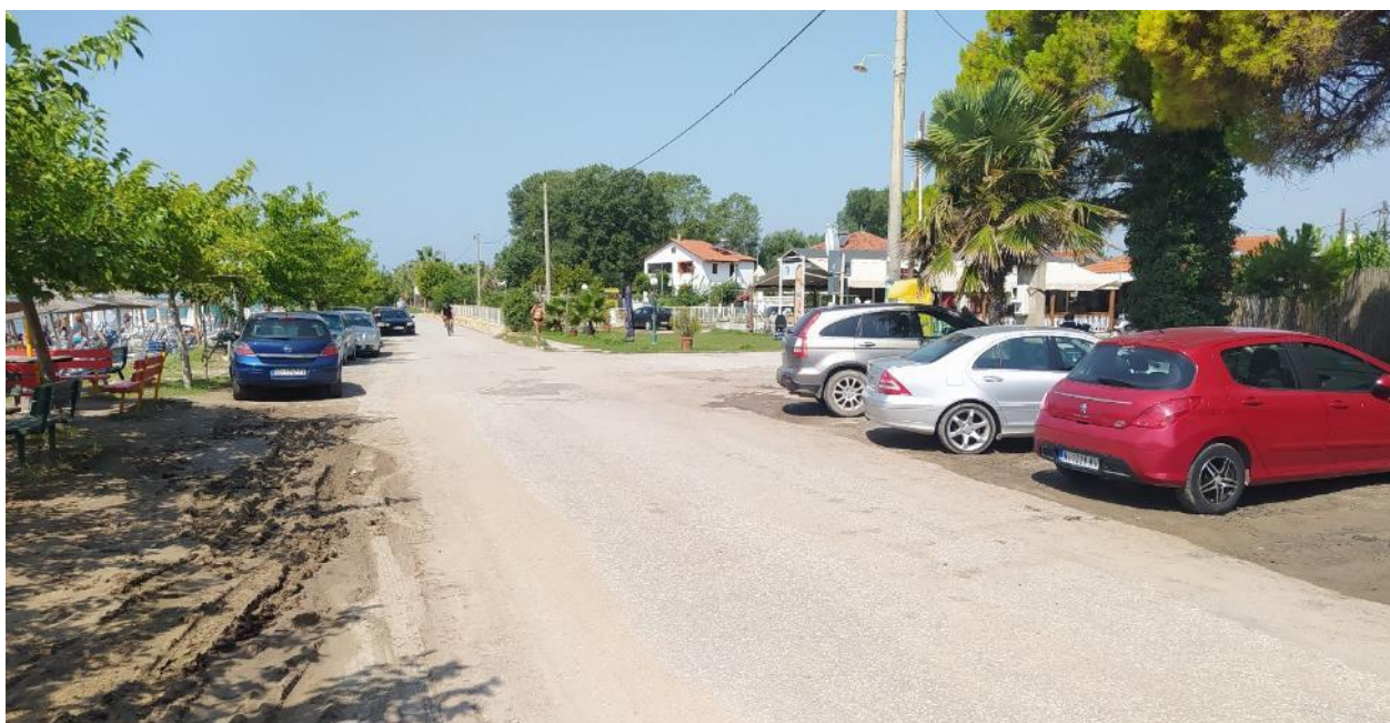
Σχήμα 8.6: Διαμόρφωση παραλιακής οδού στην τοποθεσία «Μυκονιάτικα» (Αύγουστος 2022)
